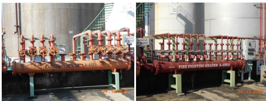
รูปที่ 1.8.3-4 ท่อดับเพลิง และ Air foam Header Zone 2: A- Area ที่มีการติดตั้งวาล์วเปิดม่านน้ำ Zone 2: A- Area
