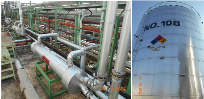
รูปที่ 1.16-6 Insulation , Vapor line, Heat exchanger และ N 2 Blanket Unit & Seal pot ที่ TA.001/011/010/108/111/305
