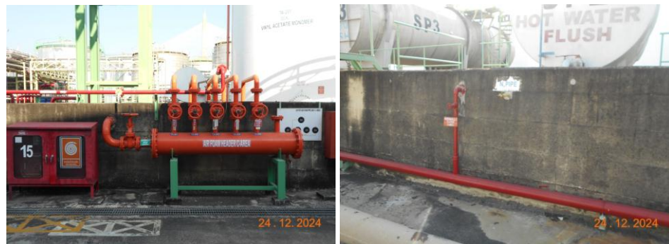
รูปที่ 1.8.3-6 (ซ้าย) ท่อดับเพลิง และ Air foam Header Zone 3 : C-Area และ (ขวา) กำแพงคอนกรีตเสริมเหล็กสูงประมาณ 1.15 เมตร หนาประมาณ 0.15 เมตร
