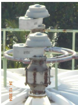
รูปที่ 2.4-1 ระบบควบคุมการระบายอากาศเข้า-ออก ภายในถัง โดยติดตั้ง Automatic Breather Valve ซึ่งทำหน้าที่ปรับความดันภายในถังและนอกถังให้อยู่ในสภาวะสมดุล
