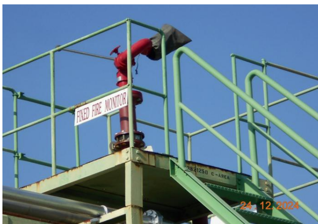
รูปที่ 1.8.3-7 หัวฉีดน้ำดับเพลิงที่ C- Area
