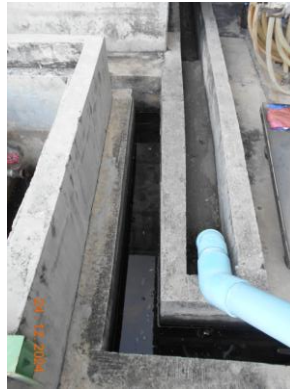
รูปที่ 2.1-4 รางระบายน้ำรอบลานถังเคมี (ทุก ZONE) ที่จะเข้าบ่อแยกน้ำมัน (Oil Separator) มีการทำความสะอาด ทุกๆ เดือน หรือในระยะเวลาที่เหมาะสม ถ้าเห็นว่าภายในบ่อมีคราบสกปรก และตะกอนตกค้างมาก เพื่อลดตะกอนและคราบน้ำมันที่จะเข้าสู่ระบบบำบัด
