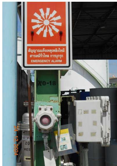
รูปที่ 1.8.3-16 สัญญาณแจ้งเหตุฉุกเฉิน ที่โรงเก็บถังใหม่ติดกับ F- Area
