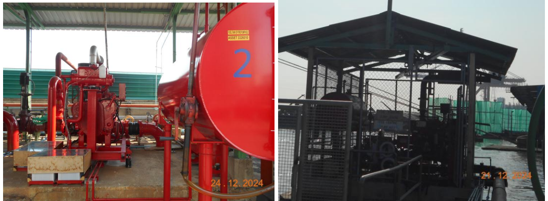
รูปที่ 1.16-3 เปลี่ยนปั๊มดับเพลิงหมายเลข 2 และหมายเลข 3 มีอัตราเร็วในการดูด 1500 gpm.
