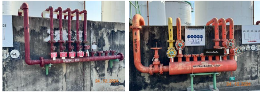
รูปที่ 1.8.3-13 ท่อดับเพลิง และ Air foam Header Zone 6 : E-Area
