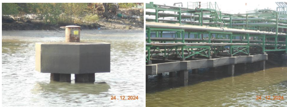
รูปที่ 1.16-9 ช่อมแซมเสา Dolphin บริเวณหน้าท่า และช่อมแซมโครงสร้างคอนกรีตของท่าเทียบเรือ
