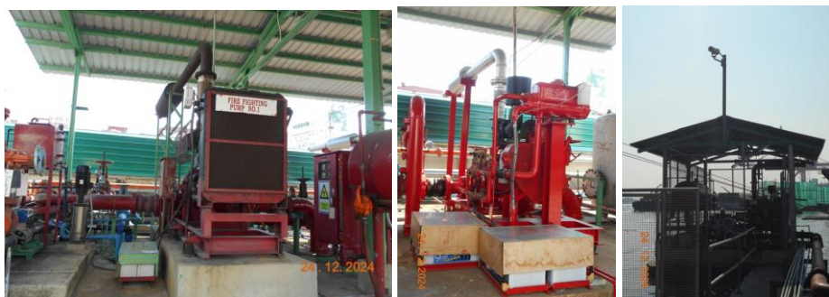
รูปที่ 1.8.10-1 เครื่องสูบน้ำเครื่องที่ 1, 2 และ 3 ตามลำดับ (Fire Pump)
