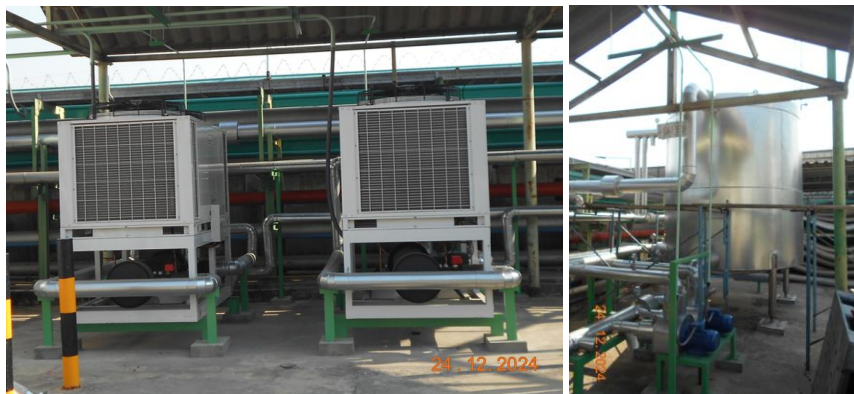
รูปที่ 1.16-7 ติดตั้ง Chiller ตัวใหม่ 2 เครื่องและแท็งก์น้ำความจุ 10,000 ลิตร
