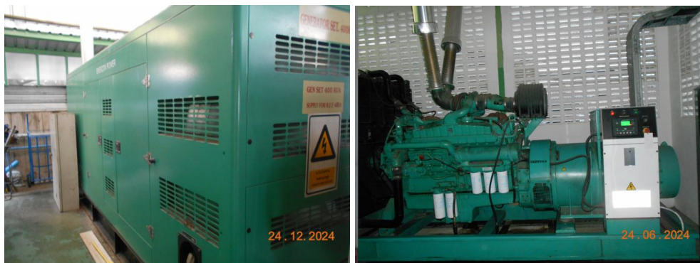
รูปที่ 1.8.15-1 Generator ขนาด 800 KVA ที่ห้อง Air Compressor (ซ้าย) Generator ขนาด 400 KVA ที่ Workshop (ขวา)
