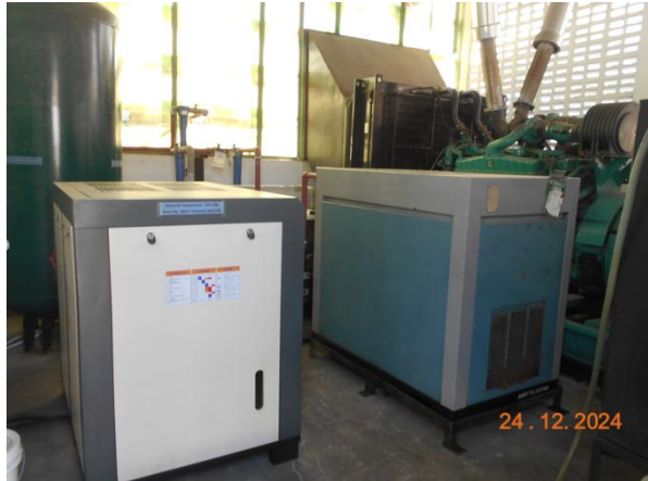
รูปที่ 1.8.11-1 เครื่องอัดลม (Air Compressor) และเครื่องทำลมแห้ง (Air Dryer)
