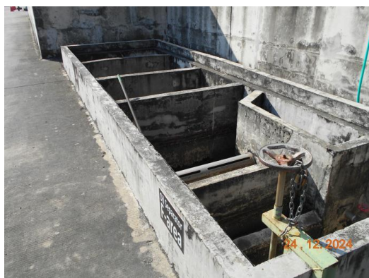
รูปที่ 2.1-3 บ่อแยกน้ำมัน (Oil Separator) มีการทำความสะอาดเป็นประจำสม่ำเสมอเดือนละครั้งหรือในระยะเวลาที่เหมาะสม ถ้าเห็นว่าภายในบ่อมีคราบสกปรก และ ตะกอนตกค้างมาก
