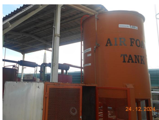
รูปที่ 2.5.3-4 ถังแอร์โฟมดับเพลิงภายในโครงการ
