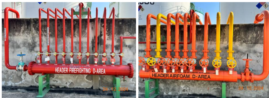
รูปที่ 1.16-4 ย้ายตำแหน่งของ Header fire fighting & Airfoam บริเวณ Area-D
