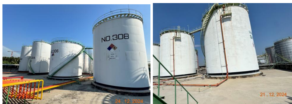
รูปที่ 1.16-13 ปรับปรุงพื้นที่ Tank yard โดยเทพื้นใหม่ บริเวณ D-Area และ E-Area
