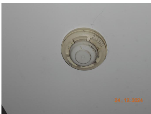
รูปที่ 2.5.3-3 เครื่องตรวจจับความร้อน (Heat detector) ไว้ที่เพดานของสำนักงาน
