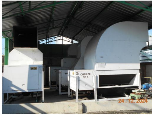
รูปที่ 2.4-3 เครื่องทำความเย็น (Chiller)
