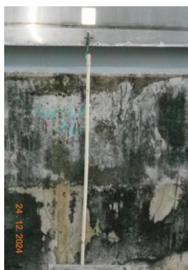
รูปที่ 2.4-2 การทำถังเก็บให้เป็นกลางโดยการต่อสายดินเพื่อป้องกันไฟฟ้าสถิตย์
