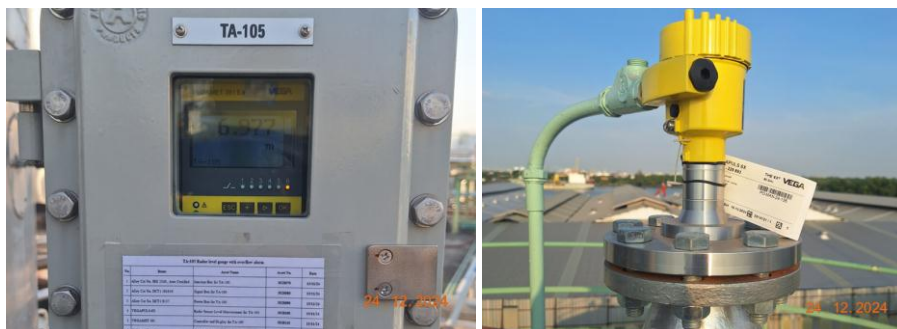
รูปที่ 1.16-8 ติดตั้ง Rader gauge & overflow alarm ที่ TA.105/114
