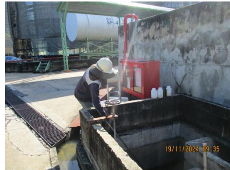
บ่อแยกน้ำมันที่ 4 (Oil separator 4) ที่ D-Area
