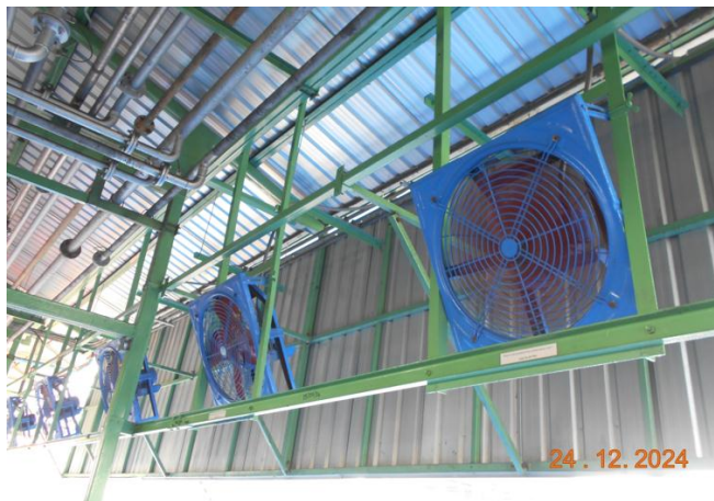
รูปที่ 1.16-2 ย้ายตำแหน่งติดตั้ง และมีการเปลี่ยนใบพัดพัดลมกันระเบิดที่โรงเดิมถึงเพื่อลดเสียงดังเวลาทำงาน
