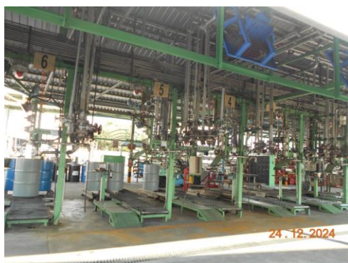
รูปที่ 1.8.7-2 สถานีจ่ายเคมีภัณฑ์ลงถัง 200 ลิตร (Drum Station) มีการติดตั้งพัดลมระบายอากาศที่บริเวณสถานีบรรจุเคมีภัณฑ์ลงถังเหล็ก
